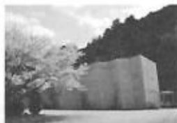
▲練習場完成(外観)
